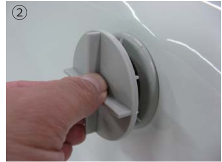
② 工具 A でオーバーフローフランジを緩める。
