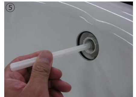
⑤ ※オーバーフローフランジを取り外した際、バスタブ裏へ落ちる可能性がある為、常に保持してください。
