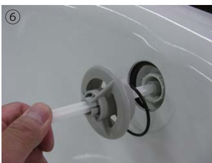
⑥ 工具 B を保持したまま、Oリング、オーバーフローフランジの順に取り付ける。
