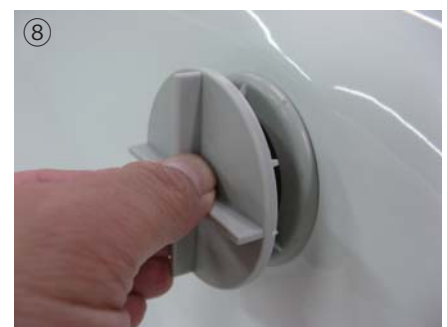
⑧ 工具 A にて増し締めをする Oリングが所定に位置にはまっているか注意する。
