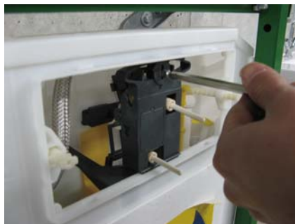
操作部の上部のスリ割りを 90 度まわしてロックを解除する
