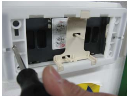
ベースプレート両側のネジを外し、ベースプレートを外す
