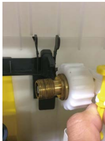
ボールタップを手前にスライドさせ、 ボールタップブラケットから外す
