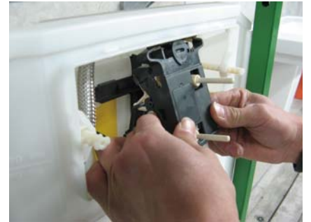
操作部を少し持ち上げ下部を手前に引いて外す
