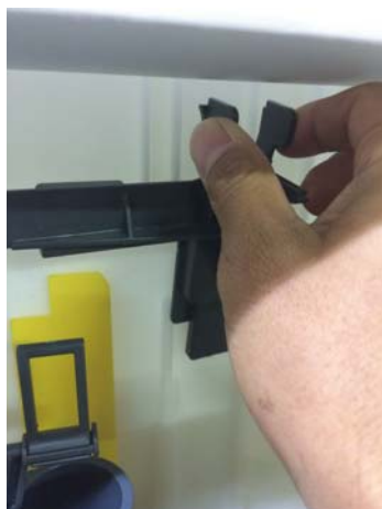
ボールタップブラケットの上部の つまみながら上にスライドして外す
