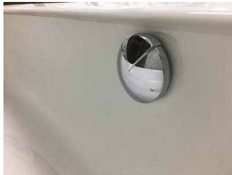
①既存の旧型ハンドルが付いた状態
