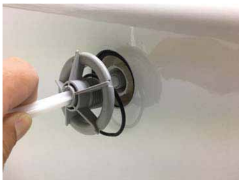
⑥ツールを保持したまま、既存のOリング、新型フランジの順にはめ、時計回りにねじ込み取り付ける
