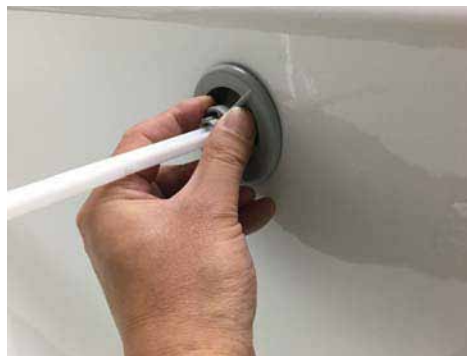
④ツールを手前に引きながら、フランジを時計と逆回りに緩め、取り外す
