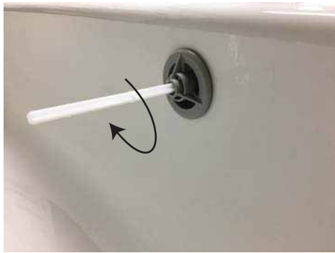
③ツールを中心の穴にねじ込む
