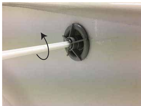
⑦ツールを矢印方向に回し取り外す
