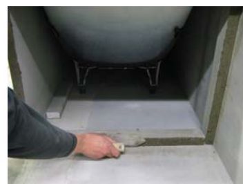
エプロン、ボードサポートの小口にモルタルをしっかりと塗りつけます。
