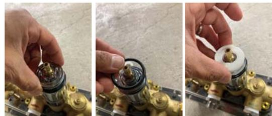
⑥逆の手順で外したパーツを取り付ける
