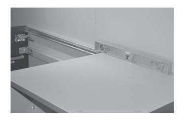
写真のように、キャビネットの上に水平器を置き家具の固定位置を確認します。
