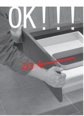
設置作業をしやすくする為にキャビネットの 引出しを取り外してください。引出しを2/3まで開き、 両サイドのスライドレールのロックを解除し引出し を上向きに取り外します。
