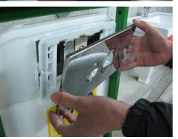
②ベースプレートの両側のネジを外し、プレートを外します
