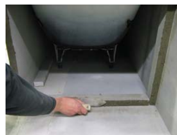
エプロン、ボードサポートの小口にモルタルをしっかりと塗りつけます。
