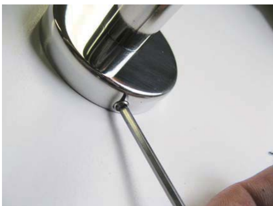
③イモネジを締めて本体をしっかり固定します。
