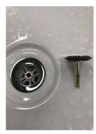
付属の吸盤で排水栓カバーを持ち上げて取り外す ベースを固定しているネジを外します。 ネジは樹脂製のため、取り扱いには注意してください。
