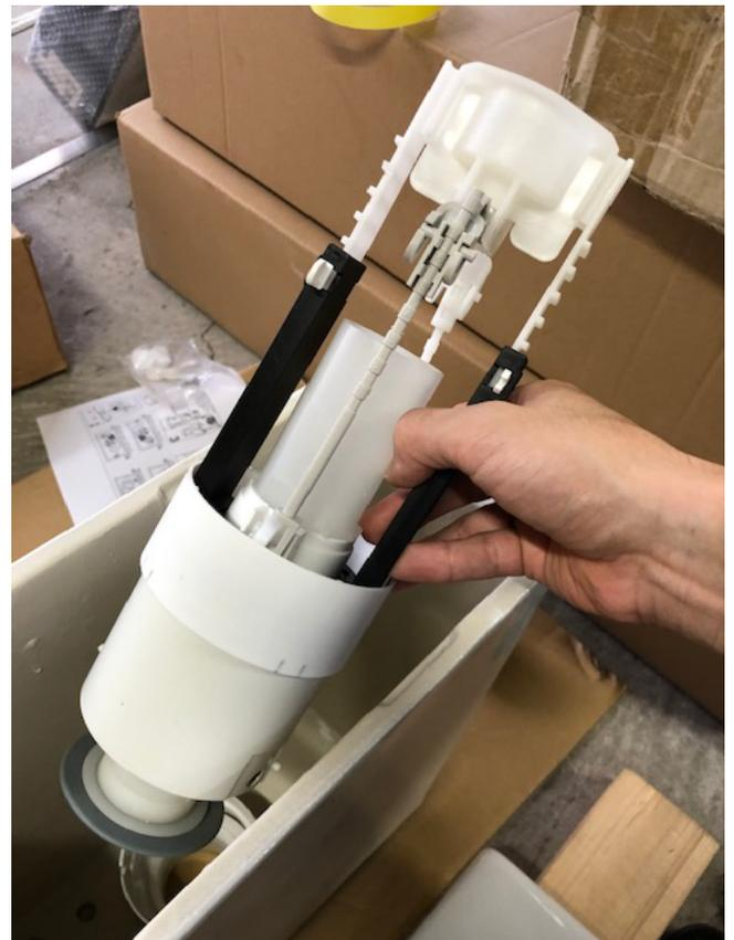
排水弁の下部を持ち、矢印の方向に回せば外れます。
