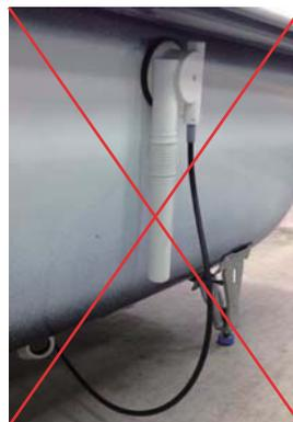
※オーバーフロー管は確実に取付けて下さい。
