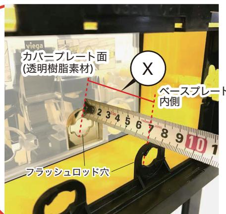
カバープレートのフラッシュロッド穴から、ベースプレートのフラッシュロッド穴までの寸法 X を測ります。
