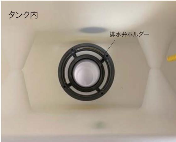
排水弁の下にセットされていますので、排水弁を取り外した状態から、まっすぐ引き抜きます。
