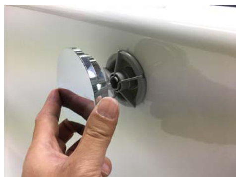
⑧新型のハンドルをはめ作業完了
