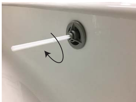
③ツールを中心の穴にねじ込む
