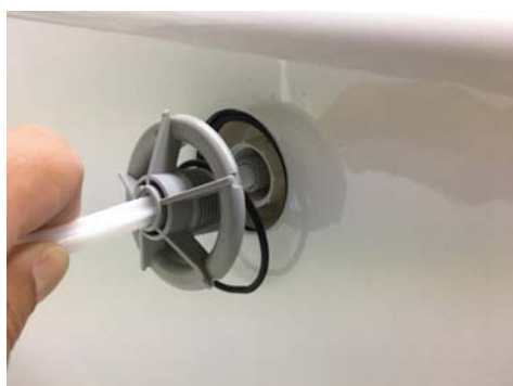
⑥ツールを保持したまま、既存のOリング、新型フランジの順にはめ、時計回りにねじ込み取り付ける
