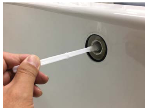
⑤フランジを取り外した状態 (裏側の部品が落ちないように常にツールを保持してください)
