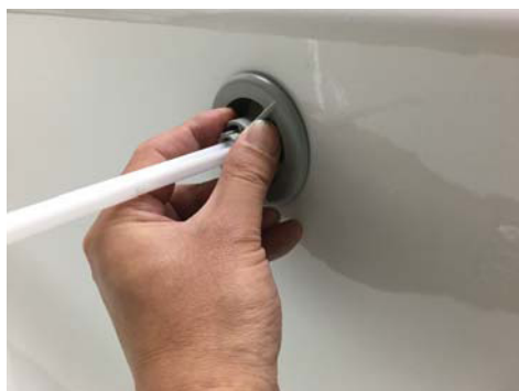
④ツールを手前に引きながら、フランジを時計と逆回りに緩め、取り外す
