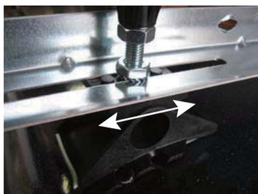
左右のアングルの出寸法を決め、ナットを締めて固定する
