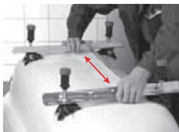
ジョイントバーに付いているボルトナットを緩め、バーを延ばします。
