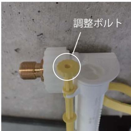
調整ボルトを回して給水量を調整します。
